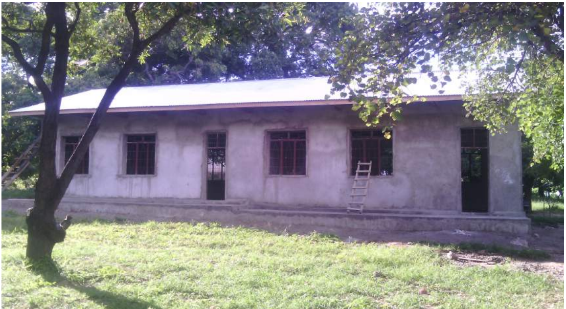
Ujenzi wa Madarasa 2 Shule ya Sekondari Milenia - Kata ya Milepa
